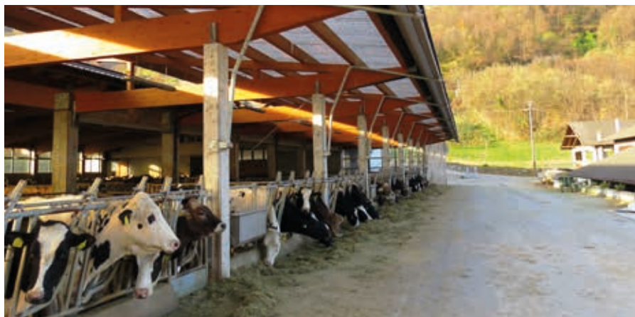
Un lato della stalla completamente aperto garantisce un'ottima ventilazione naturale
