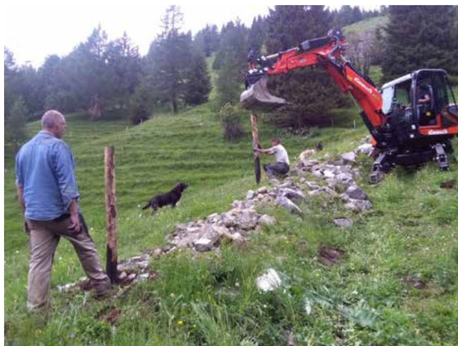
Fig. 2 - Fasi del posizionamento dei pali di legno con l'uso dell'escavatore (A. Bertagnolli).
